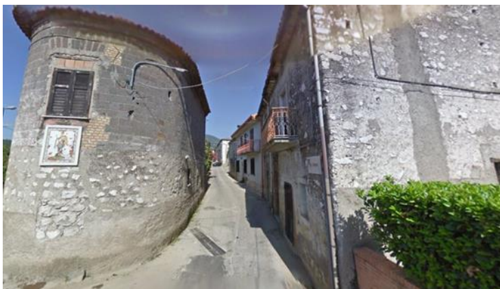
Figura 2. 7 - Veduta di Via Fontana nella frazione Petruro
