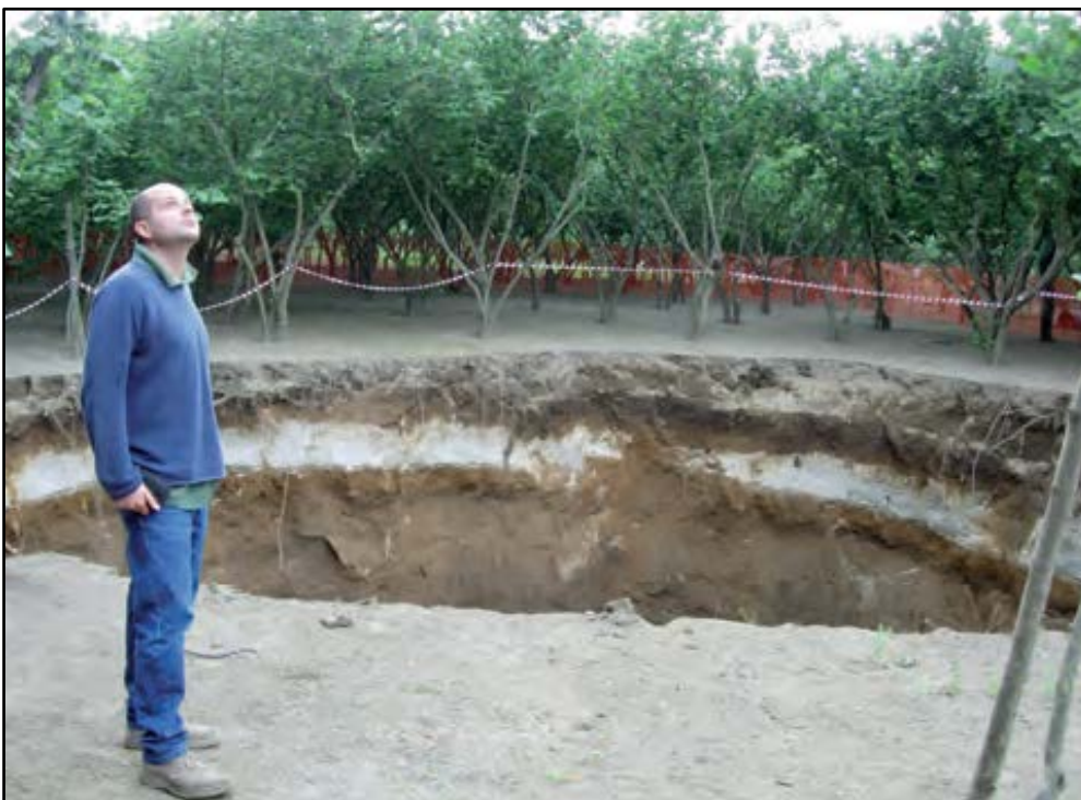
Fig. 26 - Il sinkhole SK7 di Contrada Petrosa pochi giorni dopo la sua formazione (25 giugno 2005; diametro circa 12 m e profondità di circa 25 m).
