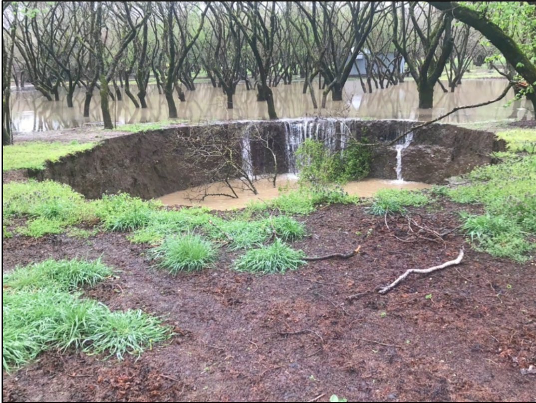
Fig. 35 - Sinkhole SK9 in località Celzi del 31 Marzo 2022.
